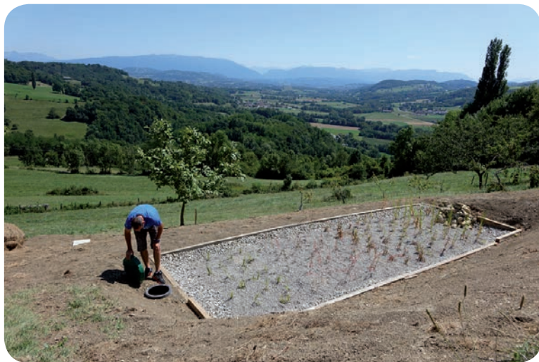
Installation d'un système d'assainissement non collectif innovant (filtre à roseaux) dans un gîte à Crempigny-Bonneguête au cours de la saison estivale 2017. Juste des plantes et des bactéries pour épurer naturellement les eaux usées de la maison
