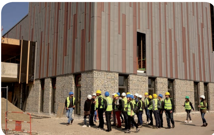
Visite du gymnase intercommunal en cours de construction à Rumilly par des membres de l'Association Ville Aménagement Durable le 11 avril 2017
