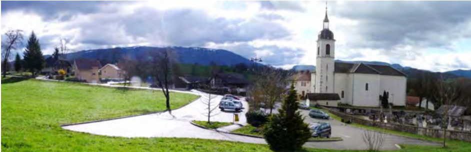
Accès à prévoir par l'Est, par le parking du cimetière et la rue de l'Eglise (qui débouche sur la D3 par un carrefour régulé par un feu tricolore)
